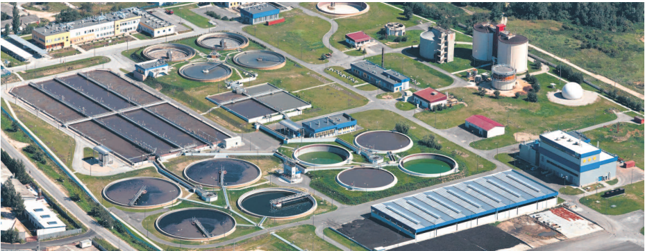
Oczyszczalnia w Sitkówce po modernizacji, z lotu ptaka
