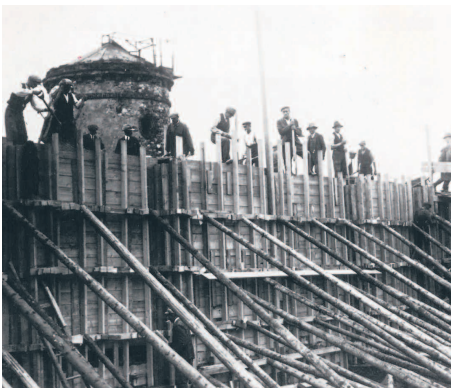
Budowa zbiornika przy ul. Żeromskiego, 1928 rok
