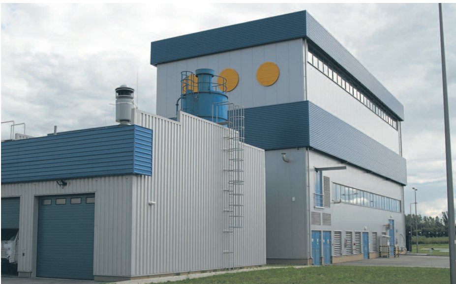
Budynek Stacji Utylizacji Osadów Ściekowych w Sitkówc
