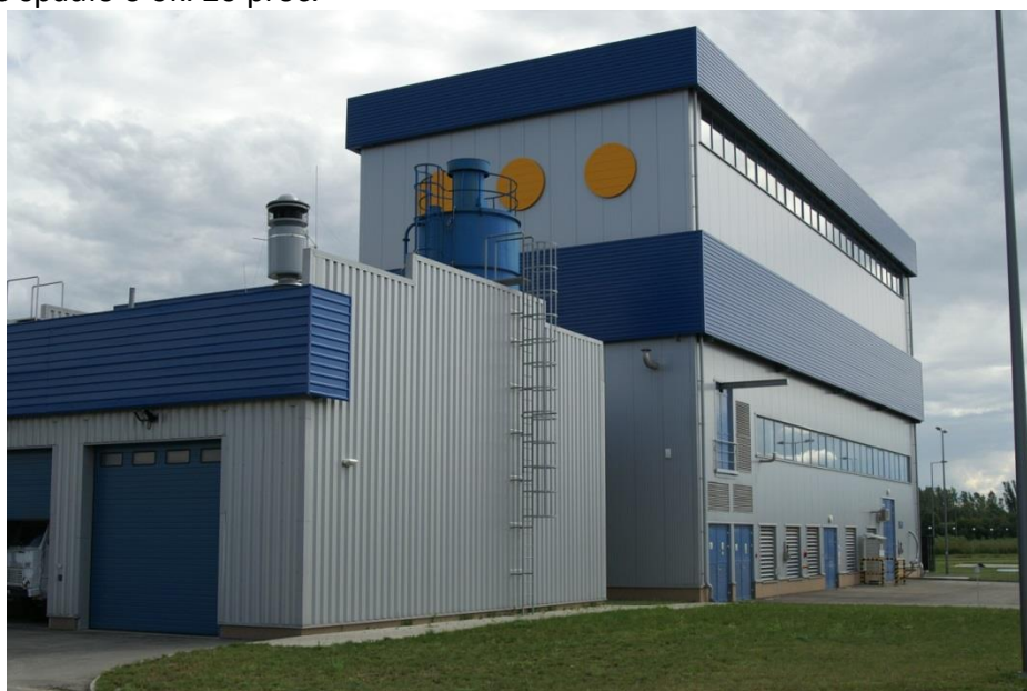
Budynek Stacji Termicznej Utylizacji Osadów Ściekowych w Oczyszczalni Ścieków w Sitkówie
