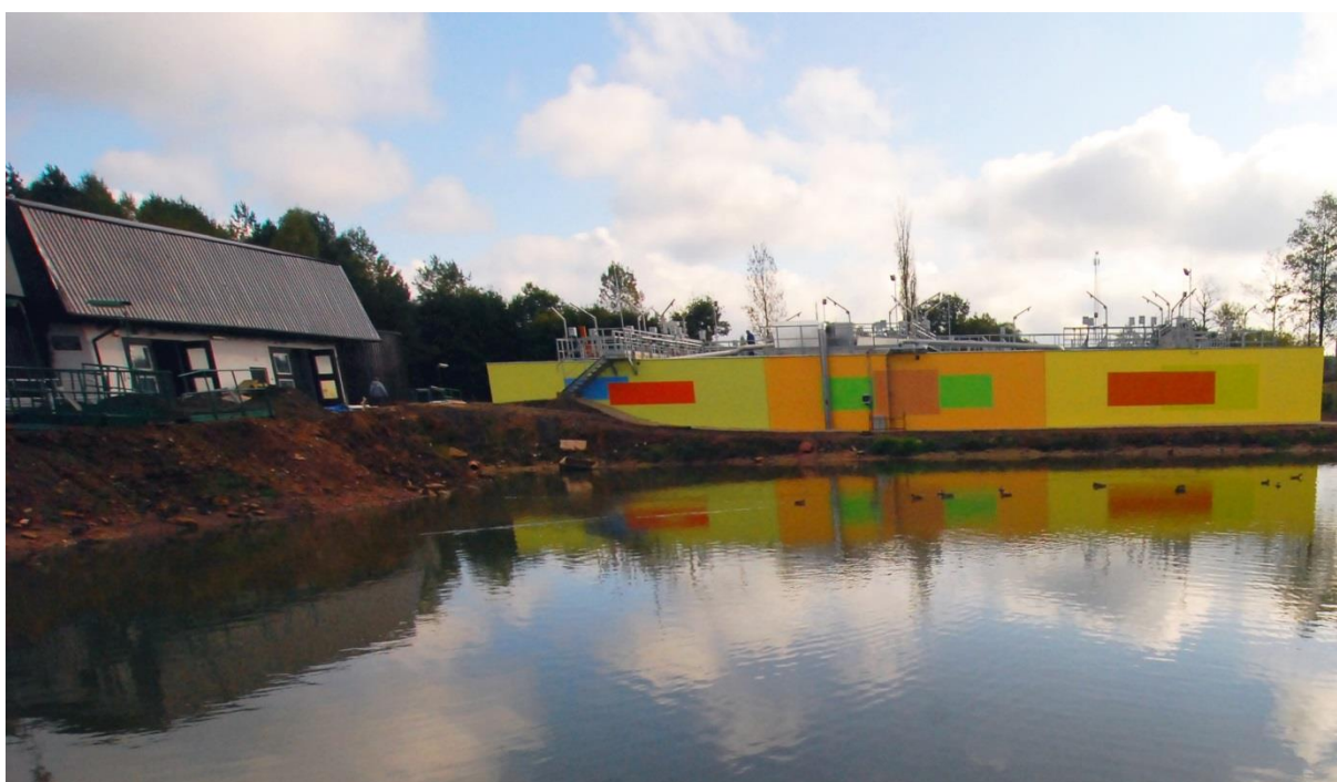
Oczyszczalnia ścieków w Bartkowie (gm. Zagnańsk)
