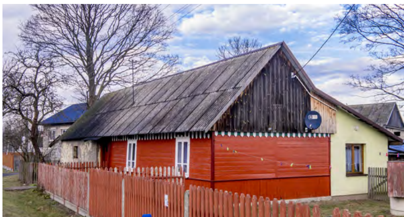
Mieszkańcy Ciekot mogą cieszyć się nowym wodociągiem
